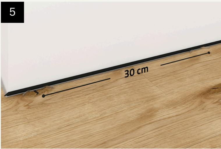
Montageclips alle 30 cm in die Abschlussleiste einsetzen.
